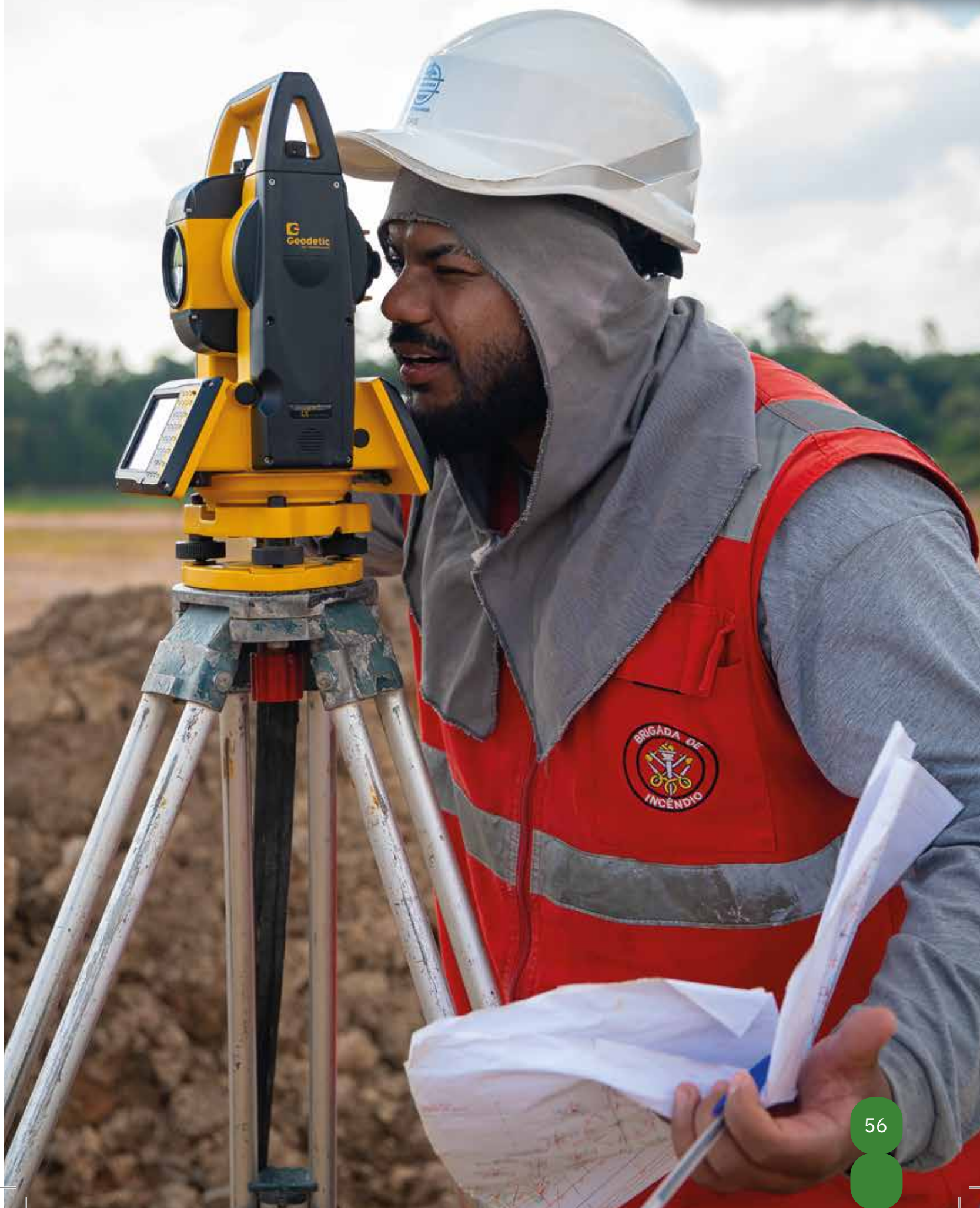
Avaliação de barragens realizado por Lucas Fernando, topógrafo do Grupo Itaquareia
