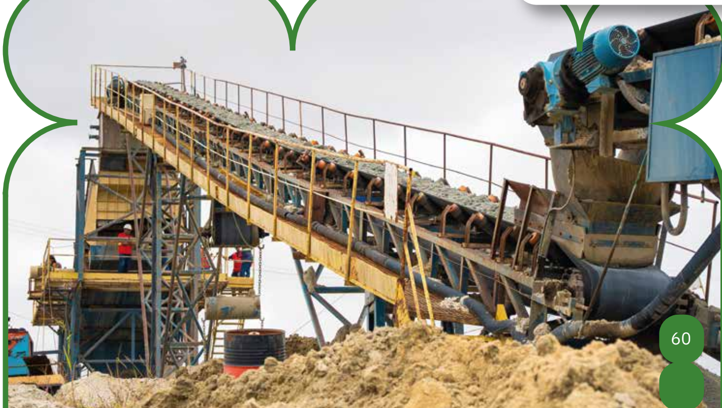
Correia transportadora elétrica, na Unidade ITA04, em Mogi das Cruzes/SP
